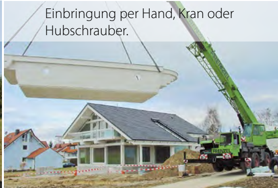
Das Becken ist werkseitig vormontiert. Schnelle und einfache Installation.
